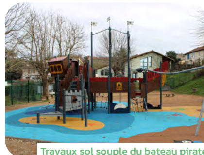
Travaux sol souple du bateau pirate
